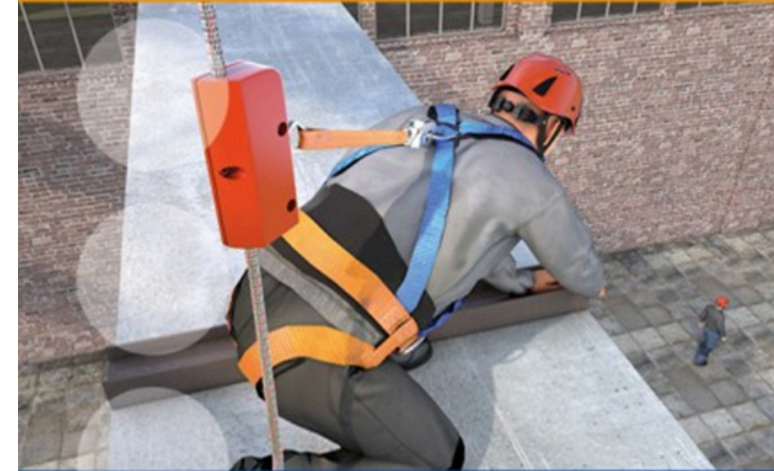
Benutzung von persönlichen Schutzausrüstungen gegen Absturz
